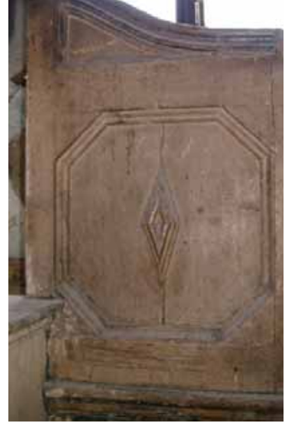
Şekil 40. Özgün Merdiven, Sahanlıkta Bulunan Korkuluk
