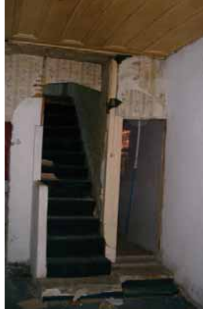
Şekil 10. Z06 Mekanı Giriş ve Üst Kata Çıkan Merdiven
