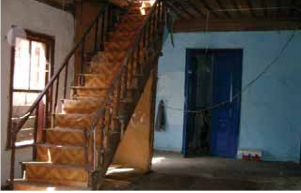
Şekil 18. 101 Mekanı, Güney Duvarı, Batı Yönünde Bulunan Merdiven
