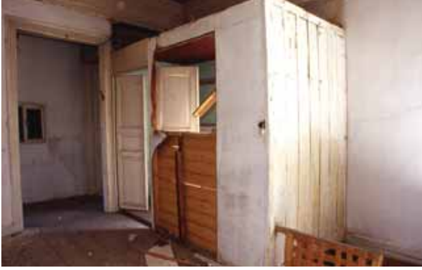
Şekil 22. 201 Mekanında Mutfak Olarak Kullanılmak Üzere Ayrılmış Kısım
