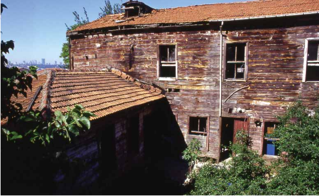
Şekil 36. Güney Cephesi Genel Görünümü
