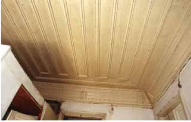
Şekil 13. Zemin Kat Ahşap Çıtalı Tavanlarından Bir Örnek (Mekan; Z03)
