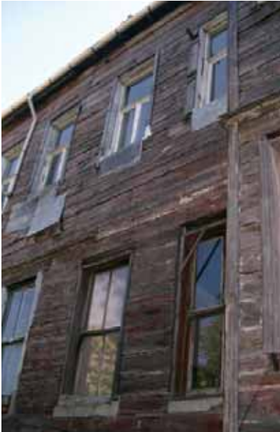
Şekil 34. Kuzeydoğu Cephesi Doğu Yönü
