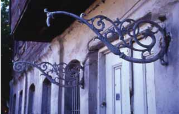
Şekil 31. Zemin Kat Giriş Kapısının İki Yanında Bulunan Lambalıklar
